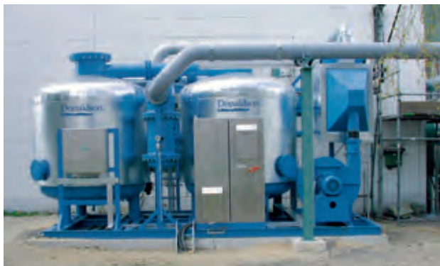
HRS-L 14000S 户外安装外加热吸附式干燥机，压缩空气处理量14000Nm 3 /h。
