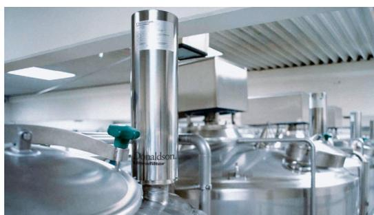
Corps de filtres pour l'aération des cuves de stockage
