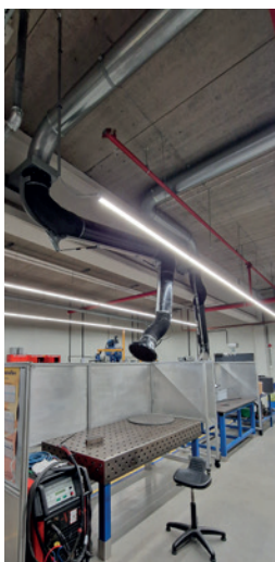
Ramiona odciągowe połączone z centralną jednostką filtrującą.
