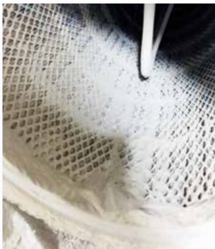
▲フィルター内部に粉じん（粉もれ状態）
