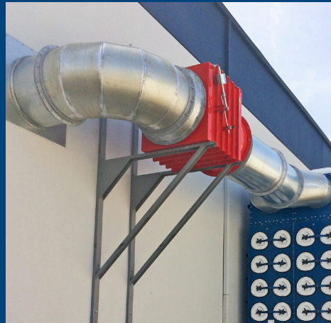
Válvula anti-retorno de explosão
