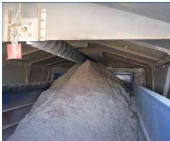
Los colectores de polvo LP Baghouse pueden equiparse con depósitos tipo caseta para proteger los depósitos de polvo de 40 yardas (36.6 mts) del clima adverso. El depósito incluye tornillos niveladores montados en el techo, los cuales distribuyen el polvo uniformemente a lo largo del depósito.
