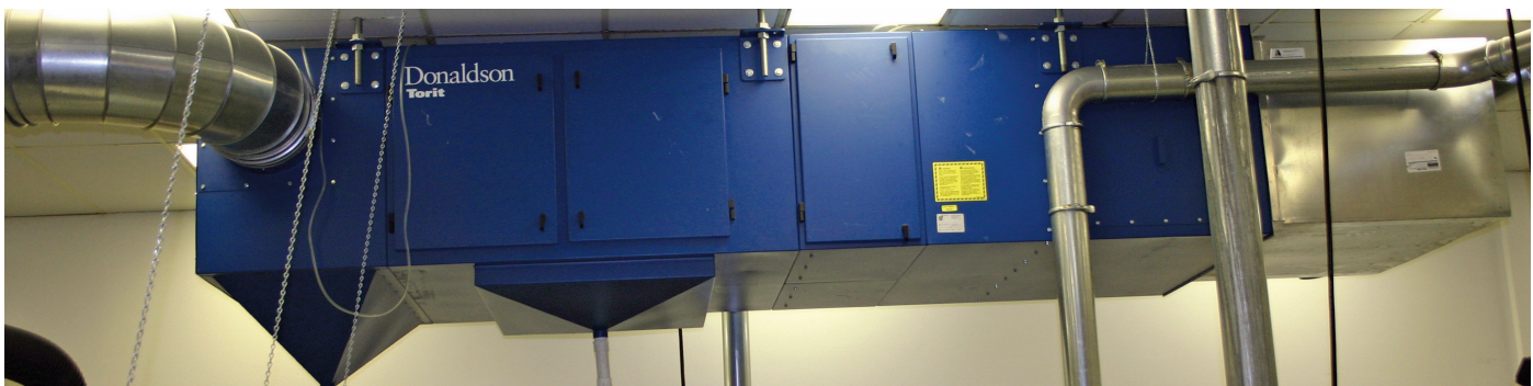
MODULAR MEDIAFILTER™ en esmerilado 2,000 cfm ( 3,397 m 3 /h)
