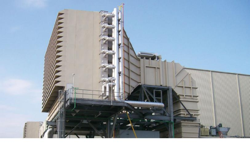
A diferencia de las casas estáticas, estas casas de filtros tienen integrado un sistema de limpieza de flujo inverso por medio de pulsos de aire comprimido, los cuales promueven la limpieza constante de los filtros cónicos-cilíndricos y con esto mantener la caída presión en valores bajos el mayor tiempo posible durante su vida útil.
